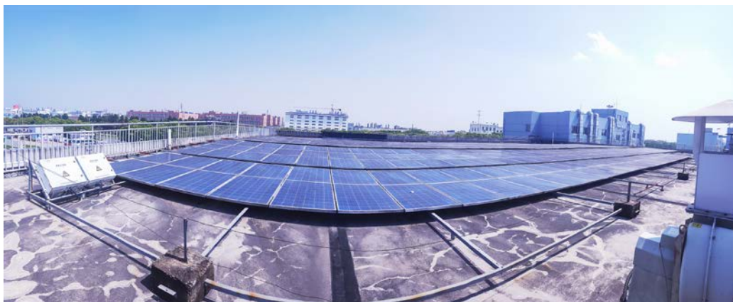
廠區光伏發電
