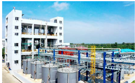
廢水預處理車間
