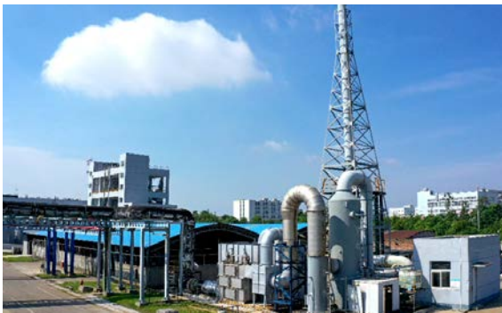
蓄熱式氧化爐(RTO)用於廢氣處理
