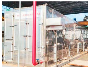
污泥干化設備
